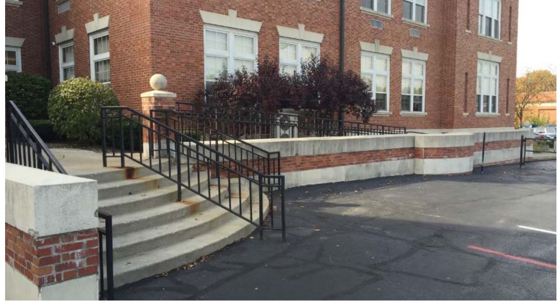
ONAWAY – EXTERIOR RAMP
